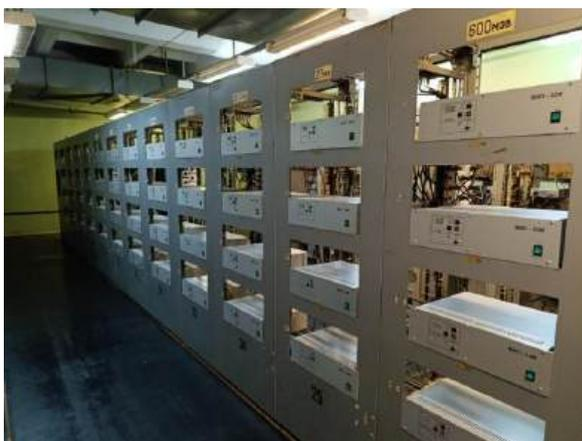
Рисунок 19 – Блок питания ВИП-32М в щитовой вакуумной системы 5-го сектора
