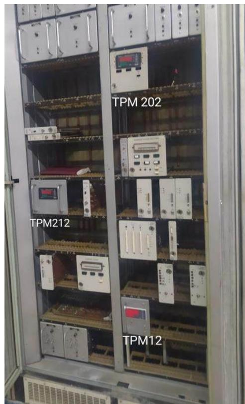
Рисунок 21 – Микропроцессорные цифровые измерители-регуляторы в шкафу МГ2.Т4
