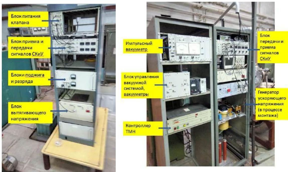
Рисунок 13 – Расположение блоков питания источника протонов в стойках на высоковольтной платформе (слева) и под потенциалом земли (справа)
